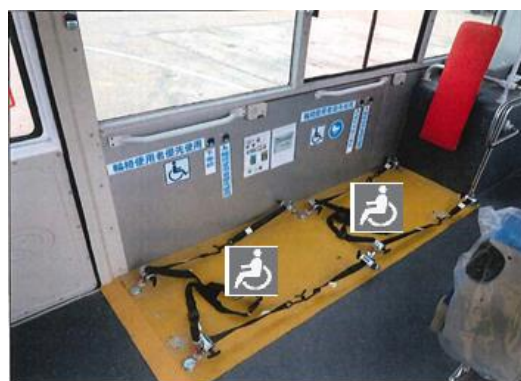
法規修正後之輪椅區禁止設置折疊椅
